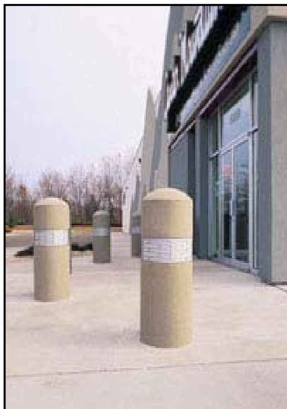
FIGURA 6.306.302.A EJEMPLOS DE TOPES VEHICULARES
