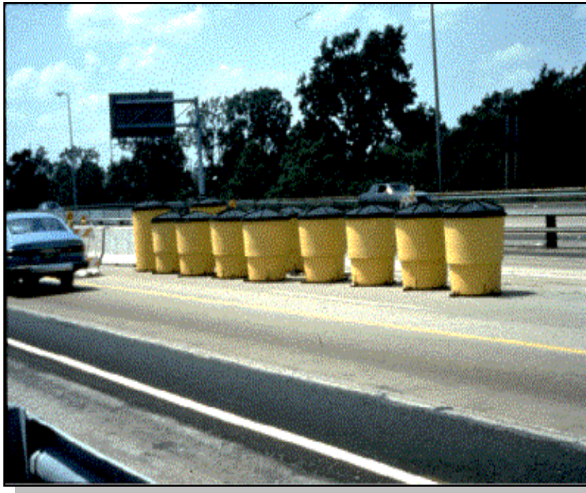
FIGURA 6.503.301.A TAMBORES DE PLASTICO CON ARENA
