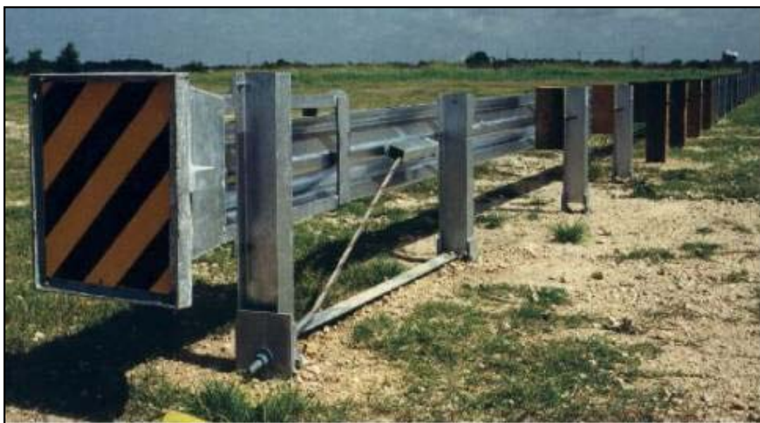
FIGURA 6.502.1206.A TERMINAL ATENUADOR DEL TIPO EXTRUSOR
