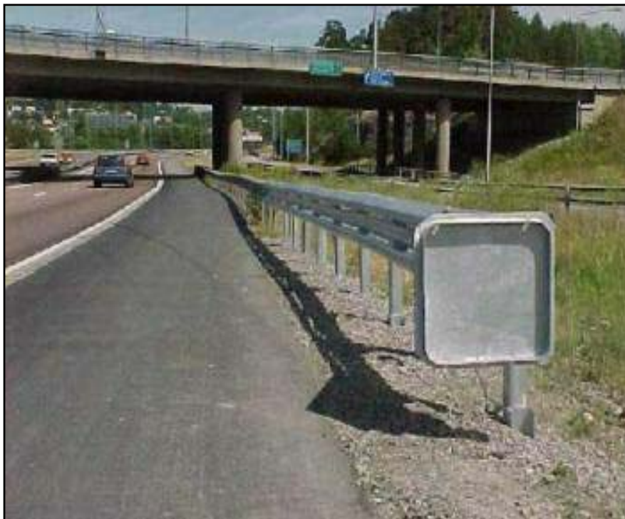
FIGURA 6.502.1206.B TERMINAL ATENUADOR DEL TIPO EUROPEO
