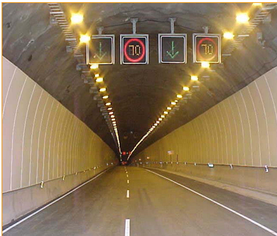
FIGURA 6.304.2.B EJEMPLO DE APLICACION DE SEÑALIZACION VARIABLE
