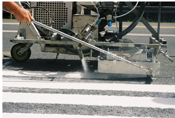
FIGURA 6.2.2. MÁQUINA APLICANDO TERMOPLÁSTICO POR EXTRUSIÓN
