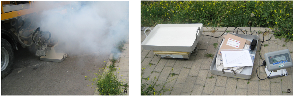
FIGURA 5.2.1. PROCESO DE AJUSTE EN OBRA. A) TOMA DE MUESTRA DEL MATERIAL SUMINISTRADO POR LA MÁQUINA EN LAS CONDICIONES DE TRABAJO PREVIAMENTE ESTABLECIDAS. B) PESADA DE LA MUESTRA TOMADA.
