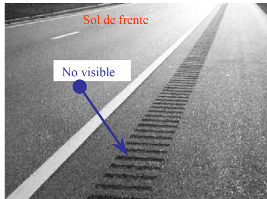
FIGURA 2.3.6. A) EJEMPLO EN EL QUE CON SOL DE FRENTE, UNA MARCA VIAL CON RESALTES PIERDE CONTRASTE DEBIDO A SU ESCASA O NULA REFLEXIÓN ESPECULAR.
