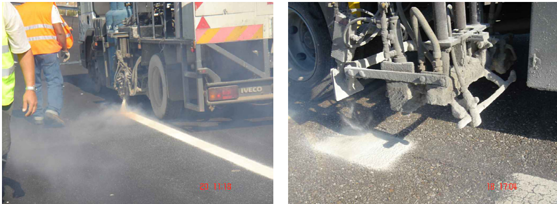
FIGURA 6.2.1. MÁQUINAS APLICANDO TERMOPLÁSTICO EN CALIENTE POR PULVERIZACIÓN
