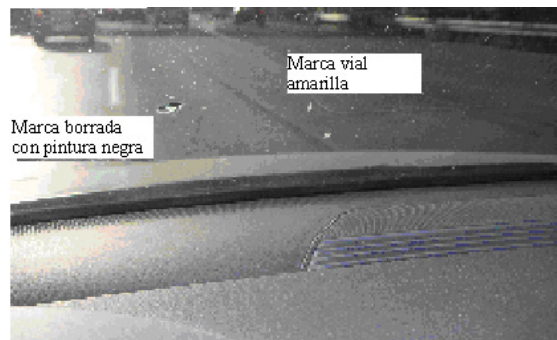
FIGURA 2.3.6. B) EJEMPLO EN EL QUE CON SOL DE FRENTE, UNA MARCA VIAL BORRADA CON PINTURA NEGRA SE HACE MÁS VISIBLE QUE LA MARCA VIAL AMARILLA DE OBRA.
