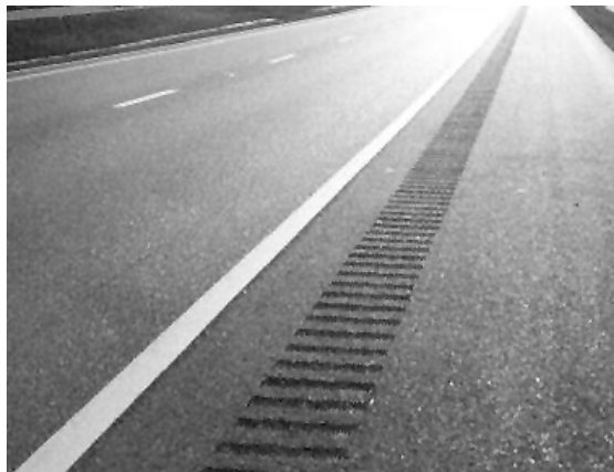
FIGURA 3.1.5. PRESENCIA DE MARCA VIAL Y RESALTES POR SEPARADO.
